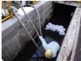
【 (MHPS)訓練の様子 左:漏出付近の養生作業 右:側溝吸着マット設置 】 【 (日立AMS)訓練の様子 左:最終水門閉鎖 右:水門オイルフェンス設置 】
