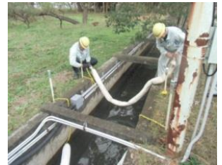
【 (MHPS)訓練の様子 左:漏出付近の養生作業 右:側溝吸着マット設置 】 【 (日立AMS)訓練の様子 左:最終水門閉鎖 右:水門オイルフェンス設置 】
