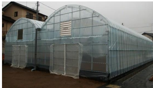
【 水耕栽培のビニールハウス外観 】
