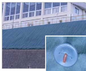
【施工例とシート固定ピン】
