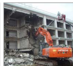
【福利施設の解体作業】
