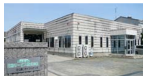
日立南リサイクルセンター外観
